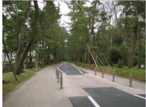
平成 21 年、歩道設置
