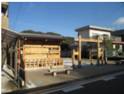
藤川宿本陣跡を活用した広場、 解説板等
