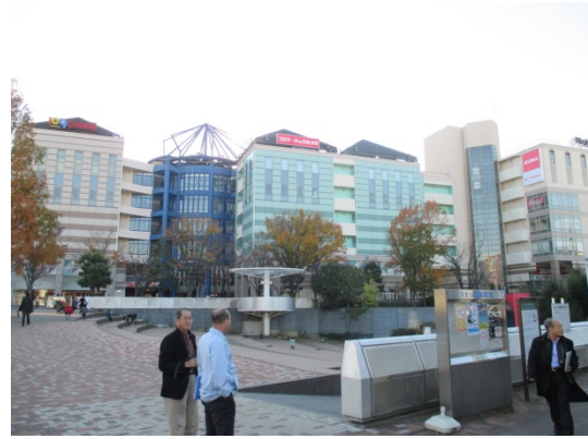
センター南駅の共同利用街区
