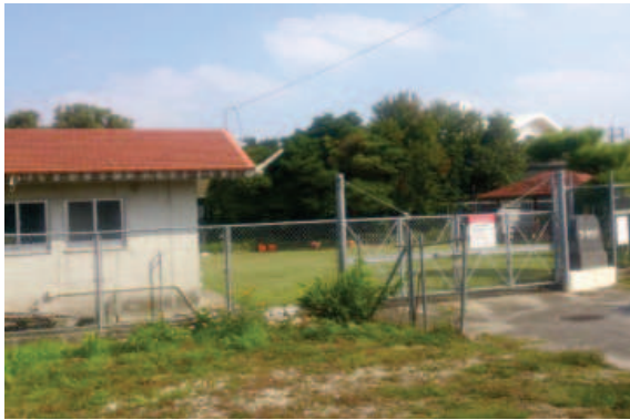
正面入口、トイレ、休憩所
