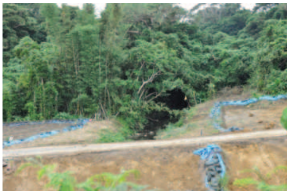
基地内巡回路の工事状況
