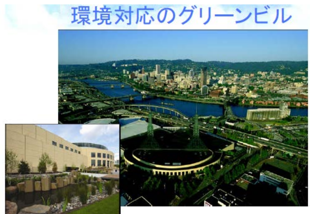
図Ⅵ-9 オレゴン・コンベンションセンター
