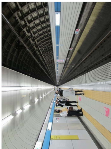
図 II-15 シールド工法で建設した地下駅の事例
