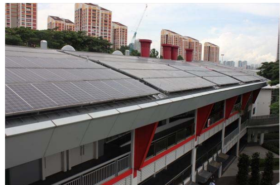
屋上の太陽光発電施設や換気塔
