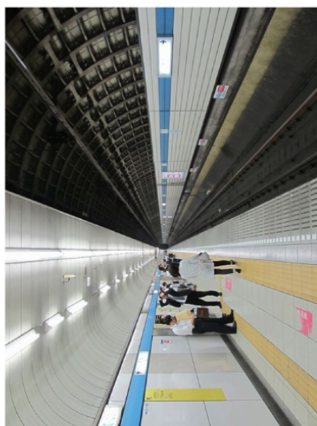
図Ⅱ-15 シールド工法で建設した地下駅の事例
