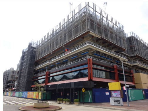
現在建設中の建物
