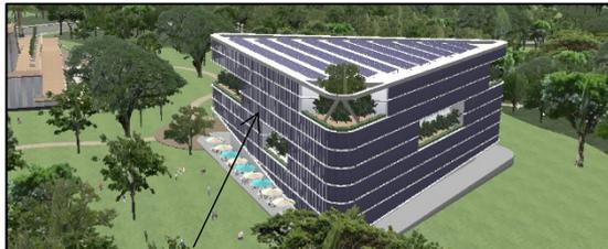
太陽光パネルを屋根・外壁全面に配置し、太陽の方向によってパネルの向きが変化することで、効率的に太陽光発電、災害時には周辺の公共施設に優先的にエネルギーを供給
