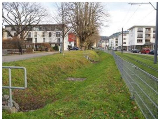
図Ⅶ-11 地区内の雨水流下の調整池
