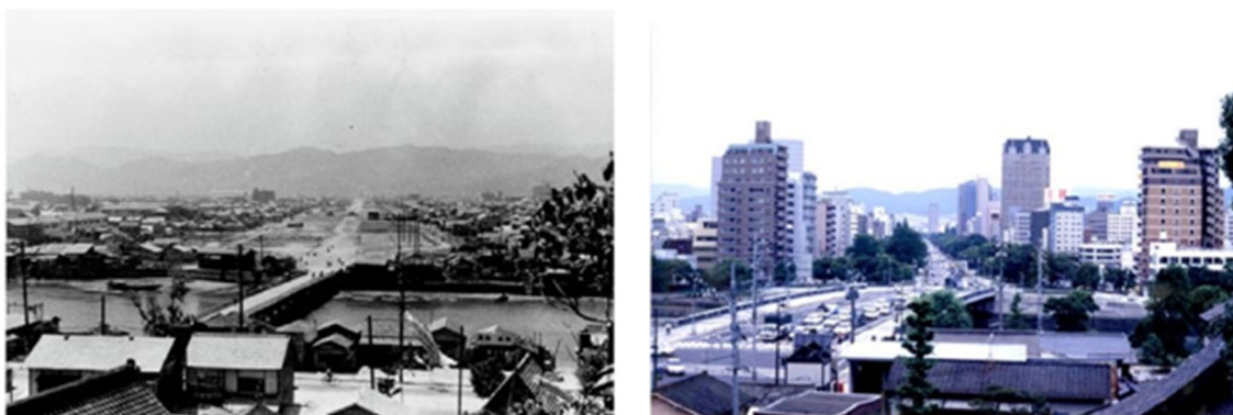
図Ⅱ-24 平和大通り（左：建設工事中、右：現在）
