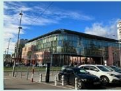
新設建築物の様子
