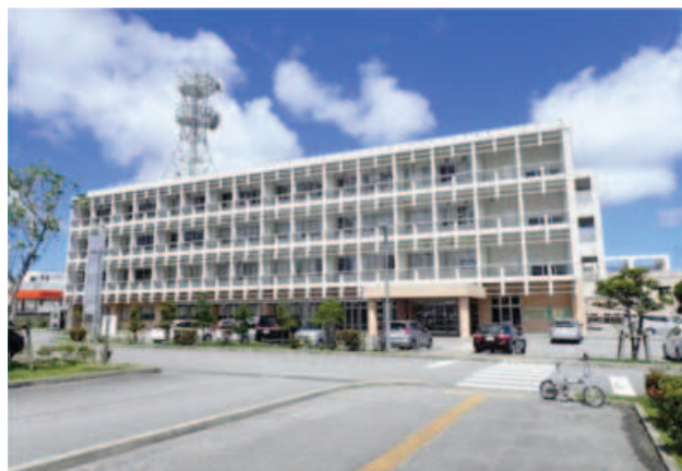
図Ⅲ-1-10 沖縄県中部合同庁舎外観
