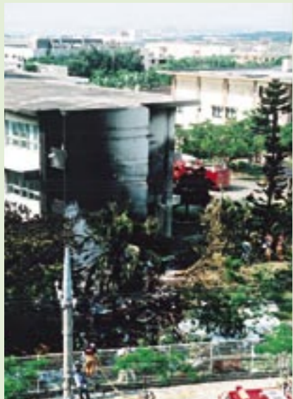
▲消火後の沖縄国際大学の本館ビル
