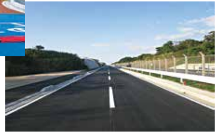
（2キロ区間）道路整備状況（R3.3）
