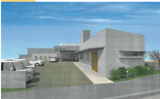
進行中 中原地区学習等供用施設建設事業
