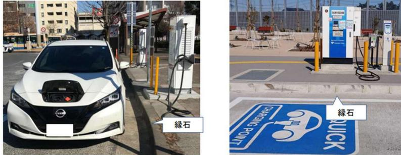
車道と急速充電設備との間に縁石を設けている事例
