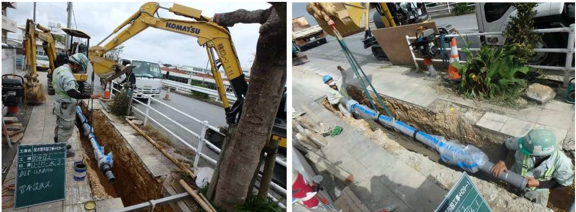
図 4.4 耐震管路布設状況
