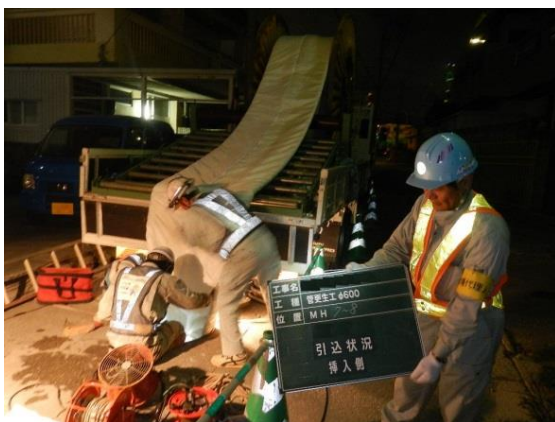
写 3.4.5 更生工法による管渠の改築更新
