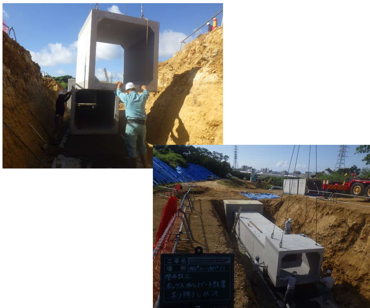
雨水管渠の整備状況
