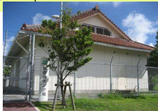
宜野湾中継ポンプ場
