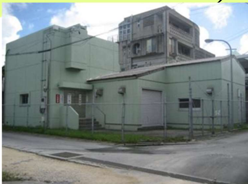
我如古中継ポンプ場
