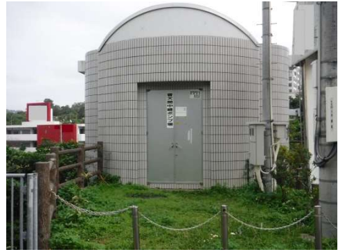
普天間中継ポンプ場
