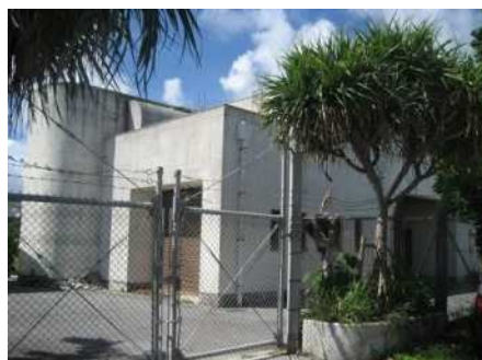
大山第一中継ポンプ場
