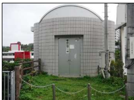
普天間中継ポンプ場
