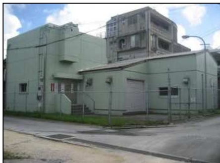
我如古中継ポンプ場
