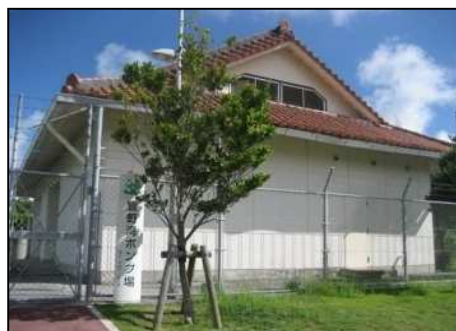
宜野湾中継ポンプ場
