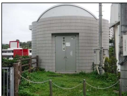
普天間中継ポンプ場
