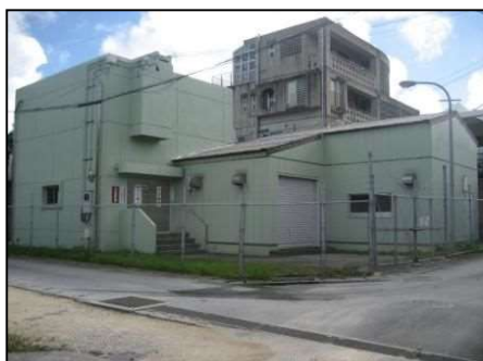
我如古中継ポンプ場
