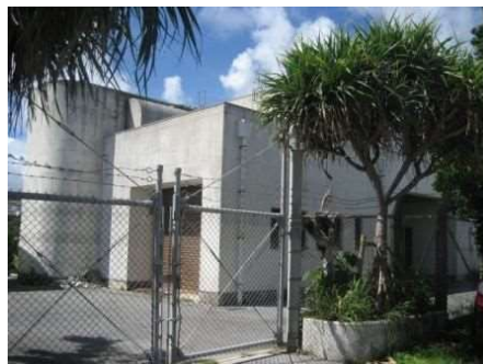
大山第一中継ポンプ場
