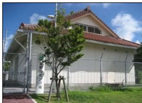
宜野湾中継ポンプ場
