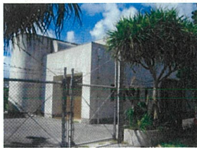
大山第一中継ポンプ場
