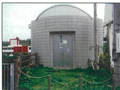
普天間中継ポンプ場
