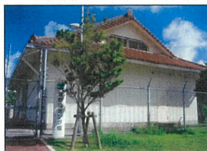
宜野湾中継ポンプ場
