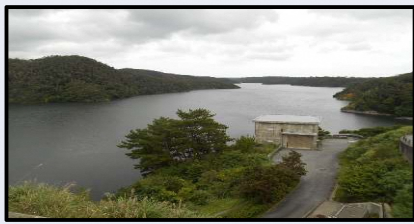
福地ダムの様子(参考: R1.6.21 100%記録時) 写真: 北部ダム統合管理事務所提供
