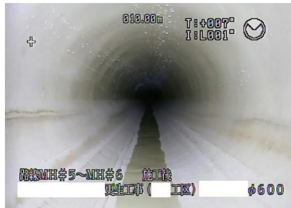
写 3.4.5 更生工法による管渠の改築更新
