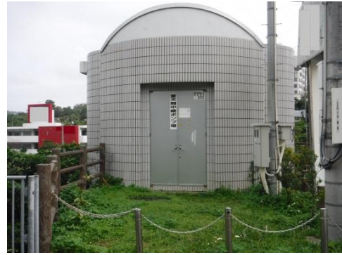
普天間中継ポンプ場
