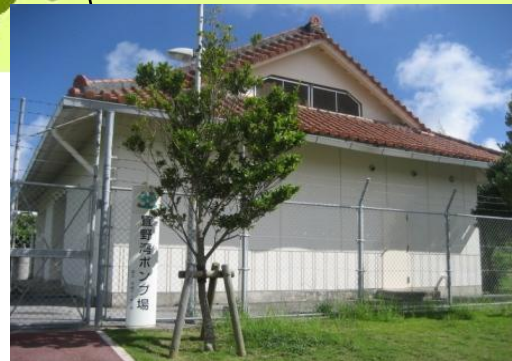
宜野湾中継ポンプ場
