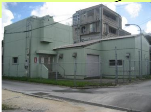
我如古中継ポンプ場
