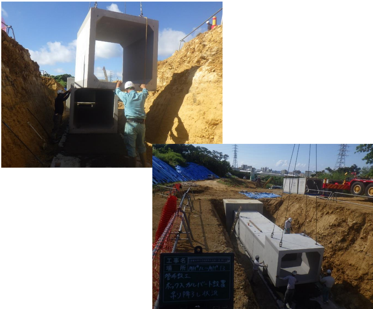
雨水管渠の整備状況
