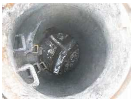
図 3.2.26 写真（人孔内部）
