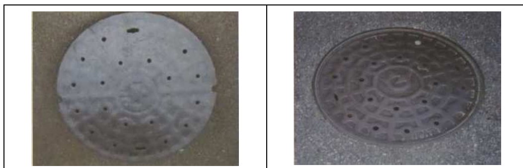
図 3.2.10 蓋表面の摩耗
