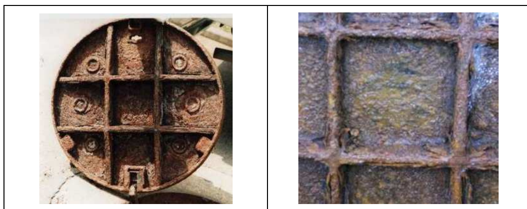
図 3.2.12 蓋裏の腐食
