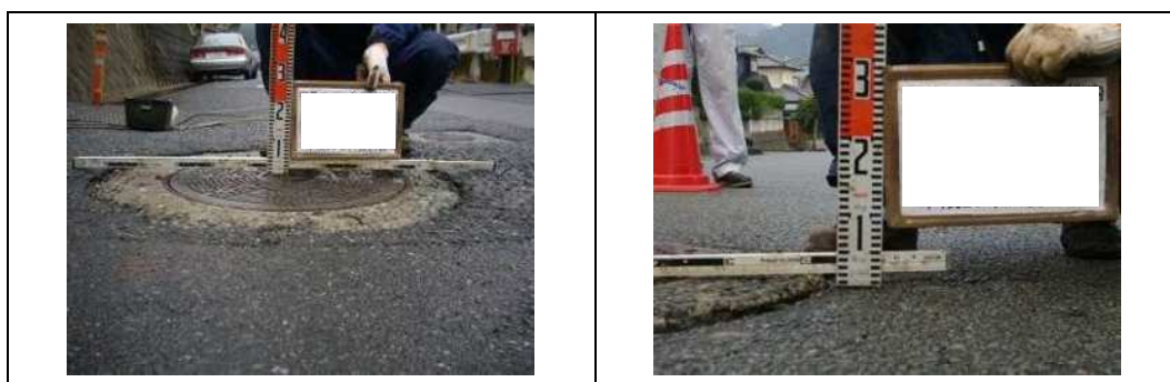
図 3.2.20 段差の測定
