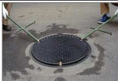
図 3.2.13 浮上防止機能の作動確認
