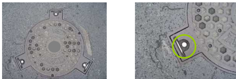
図 3.2.5 浮上防止機能例（ボルト固定式）
