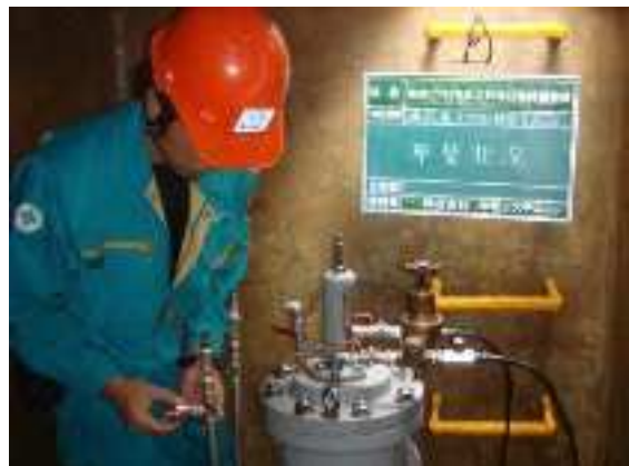
写 2.4.5 配水施設管理業務
