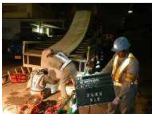
写 3.4.5 更生工法による管渠の改築更新
