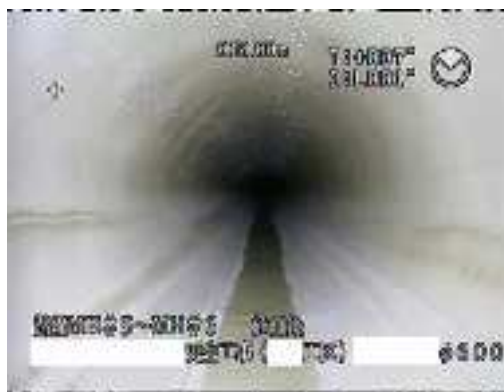
写 3.4.5 更生工法による管渠の改築更新
