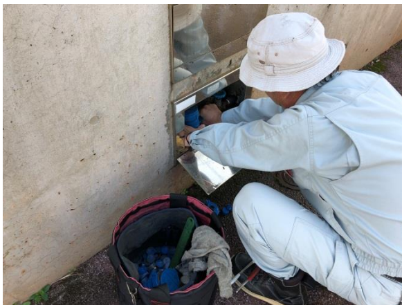
写 2.4.4 水道メーター検針及び取替業務
