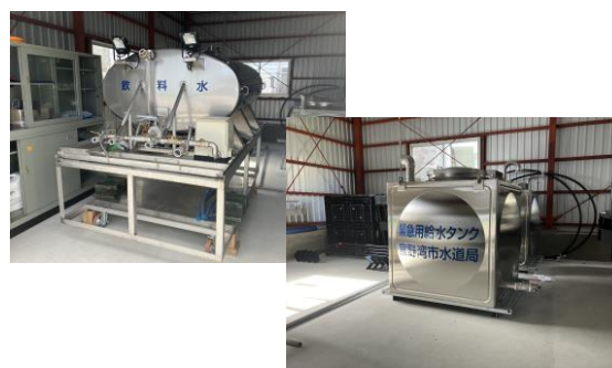
応急給水タンク【上：1.6 t(m 3 )、下：1.0 t(m 3 )】
