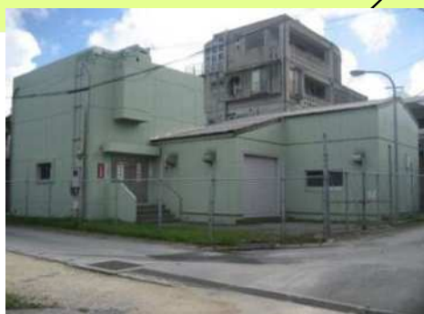
我如古中継ポンプ場
