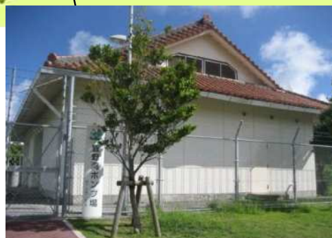
宜野湾中継ポンプ場
