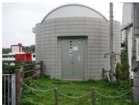
普天間中継ポンプ場
