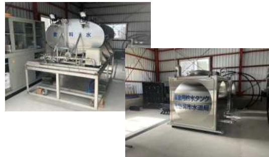
応急給水タンク【上 : 1.6 t(m 3 )、下 : 1.0 t(m 3 )】
