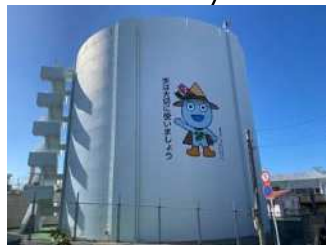
長田第2配水池
