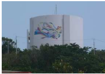
喜友名配水池
