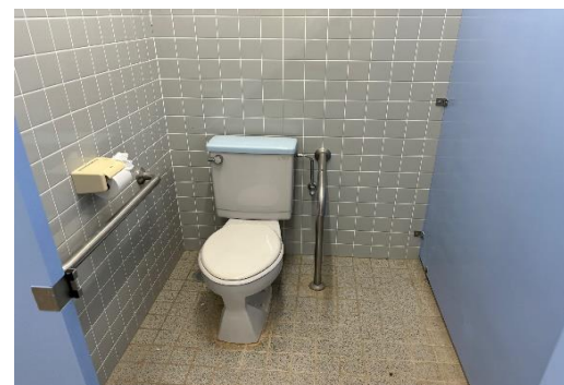
トイレ洋式化・普天間中学校体育館(施工後)
