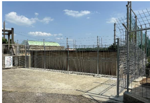
学校敷地保全対策事業(普天間中学校)
