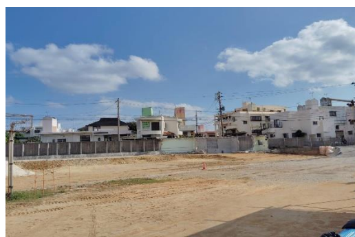
嘉数小学校水泳プール改築事業(解体)
