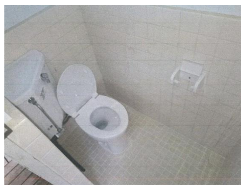
公共施設維持修繕事業(施工後:トイレ洋式化)
