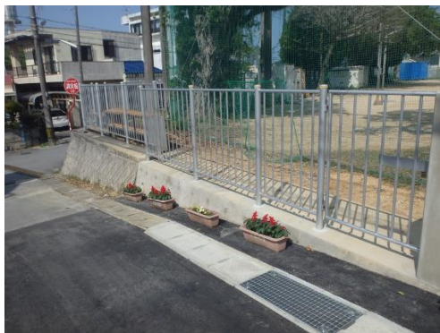
学校敷地保全対策事業(嘉数小学校)
