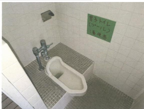
公共施設維持修繕事業(施工前:屋外トイレ)
