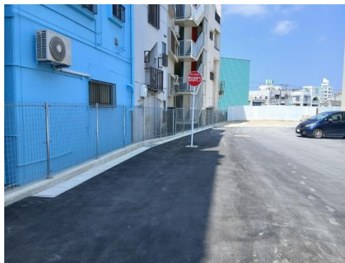
学校敷地保全対策事業(普天間小学校)
