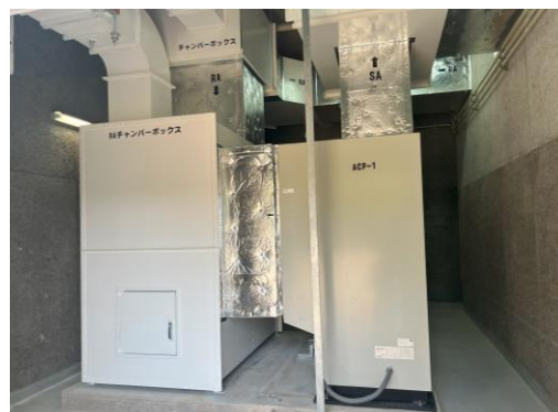
防音機能復旧事業(普天間第二幼稚園)
