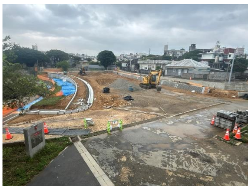
普天間小学校屋外教育環境整備事業(施工中)
