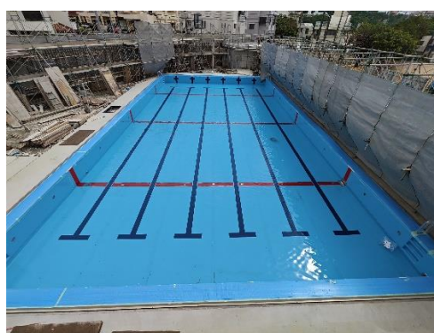
嘉数小学校水泳プール改築事業(施工中)
