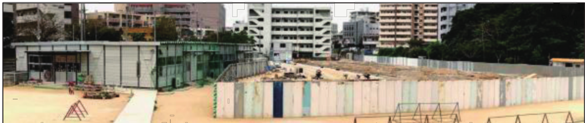
(ア) 幼稚園仮設園舎(利用中)
