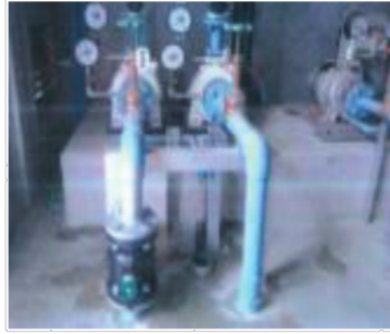
ポンプ配管修繕工事 (大謝名小学校)
