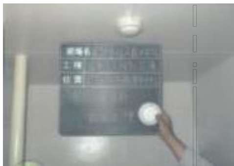
(ウ)消防設備保守点検の実施状況
