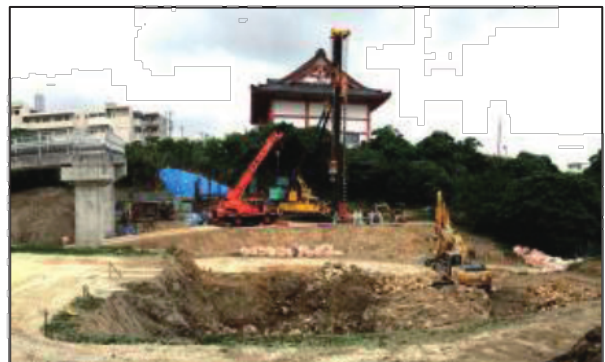
(カ) 屋内運動場増改築工事(杭工事風景)
