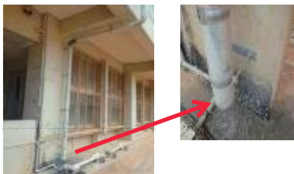
全学校雨樋の点検と補強状況
