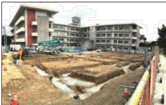
(オ) 園舎増改築工事(基礎工事風景)
