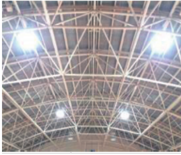
体育館照明設備取替修繕工事 (普天間中学校)
