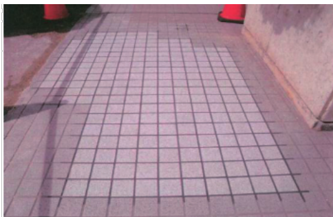
床タイルの補修
