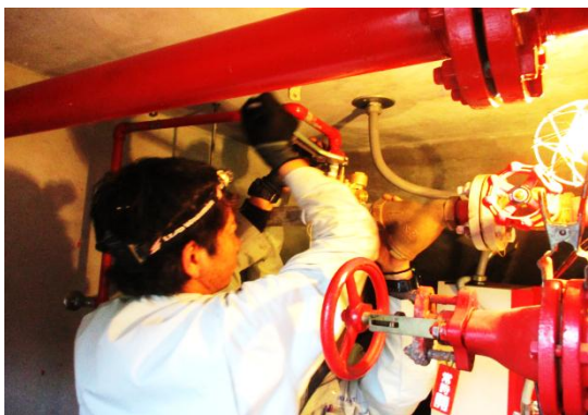
消火設備点検状況(全校)
