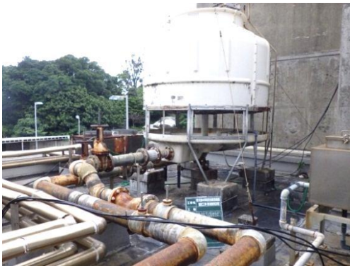
施工前(冷却塔)
