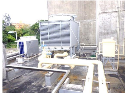
施工後(冷却塔)
