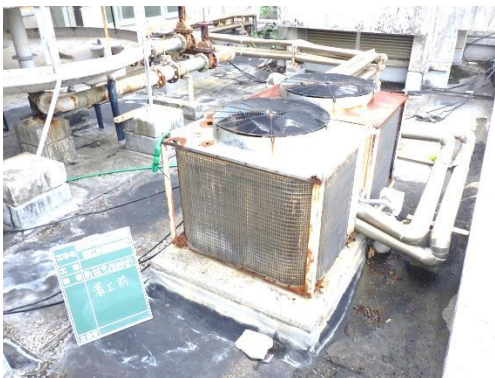
施工前(空調室外機)
