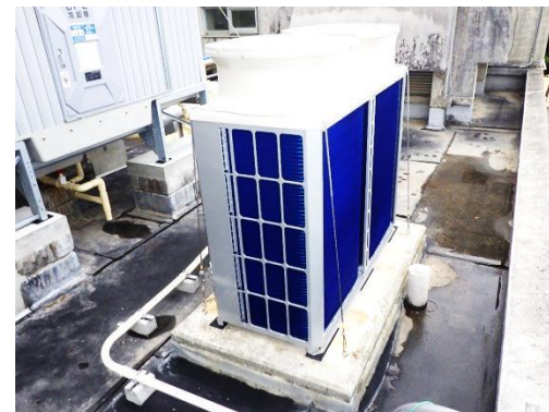
施工後(空調室外機)
