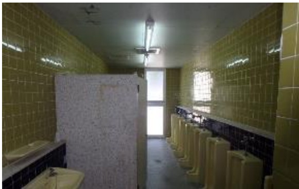
改修前【トイレ内部】
