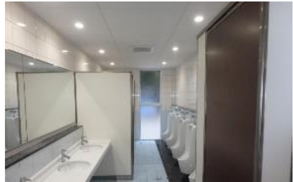
改修後【トイレ内部】
