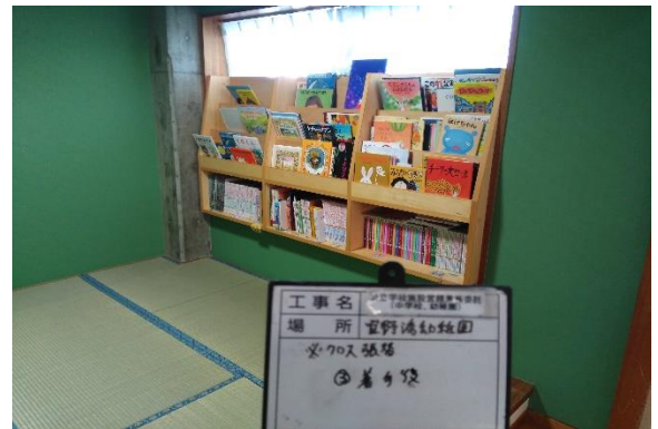
改修後【宜野湾幼稚園保育室】
