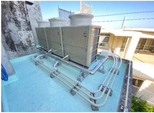
大山幼稚園防音機能復旧事業(室外機)
