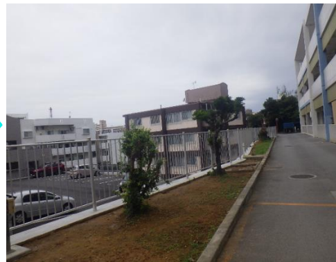
真志喜中学校敷地保全対策(竣工)
