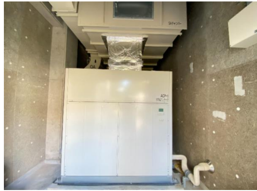
大山幼稚園防音機能復旧事業(室内機)
