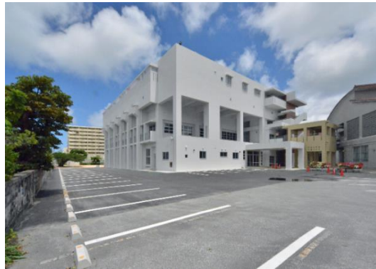
大謝名小学校・屋内運動場(完成)
