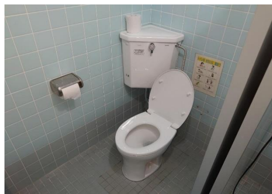
トイレ洋式化・普天間小学校体育館(施工後)
