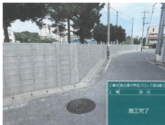
学校敷地保全対策事業(真志喜中学校)
