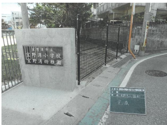
学校敷地保全対策(宜野湾小学校)
