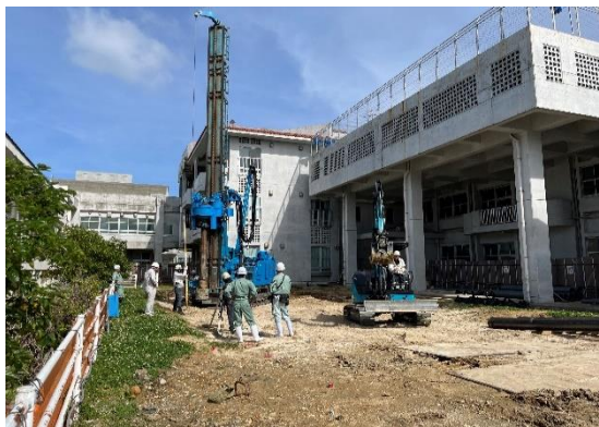
長田小学校校舎増築事業(杭施工状況)
