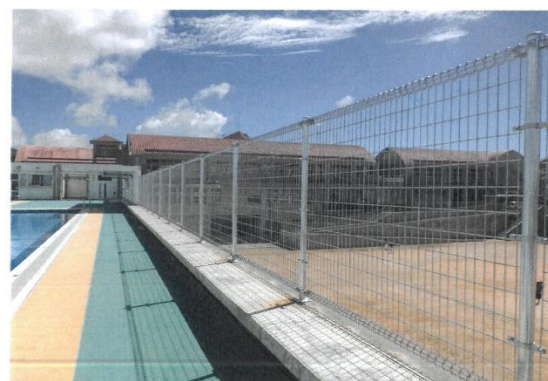
宜野湾小学校プールフェンス復旧(施工後)
