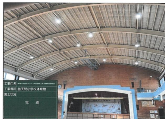
照明 LED 化改修工事(普天間小学校体育館)
