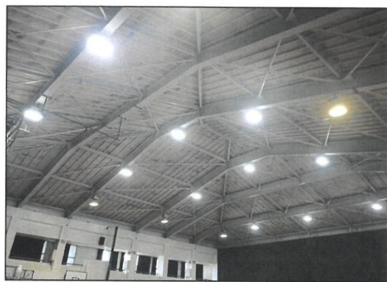
照明 LED 化改修工事(宜野湾中学校体育館)
