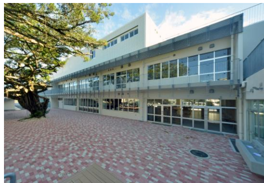
普天間小学校校舎②(ガジュマル広場)
