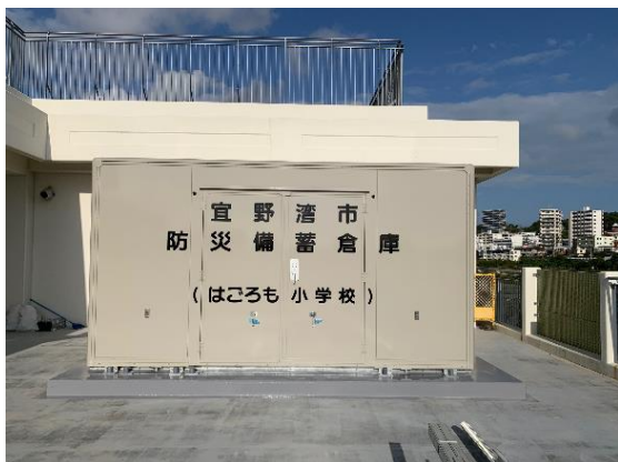
はごろも小学校備蓄倉庫設置
