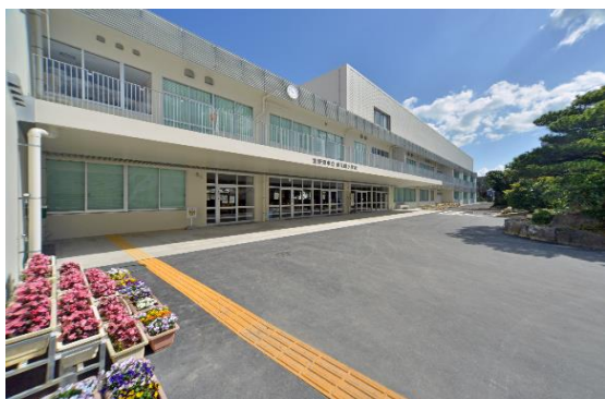
普天間小学校校舎①(昇降口)
