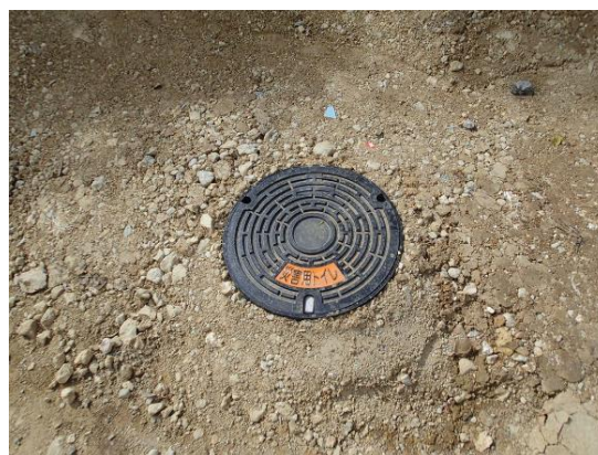
普天間小学校マンホールトイレ設置
