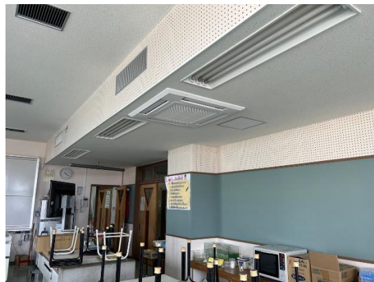
普天間第二小学校防音機能復旧(室内機)
