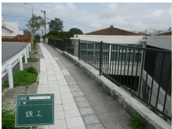
学校敷地保全対策①(宜野湾中学校)
