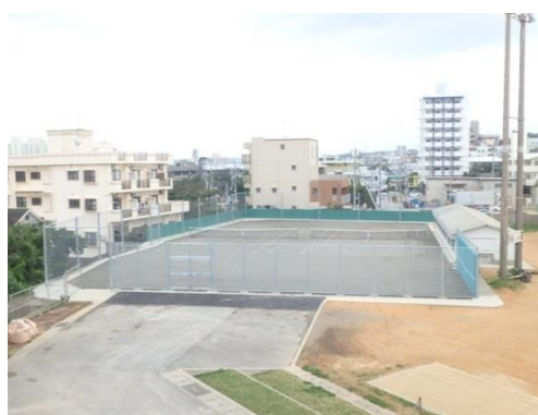
施工後(テニスコート2面)
