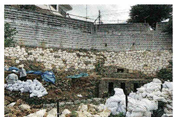
修復工事の様子
