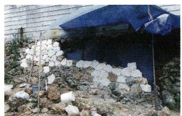
修復工事の様子
