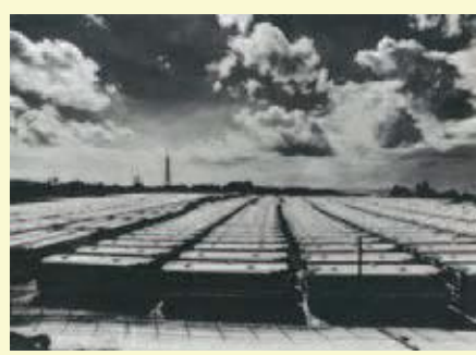
▲新車保管所(キャンプ・ブーン跡) 1978年
