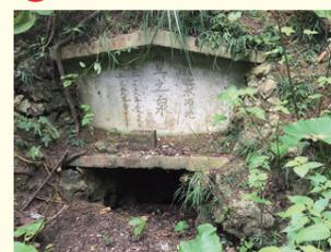
戦後すぐにシンバルガーから流れてくる水を利用して築造されました。寄棟形の壁面には着工日と竣工日が記されています。導水管が敷設され、伊佐浜の住民に水を運びました。西普天間住宅地区に所在します。
