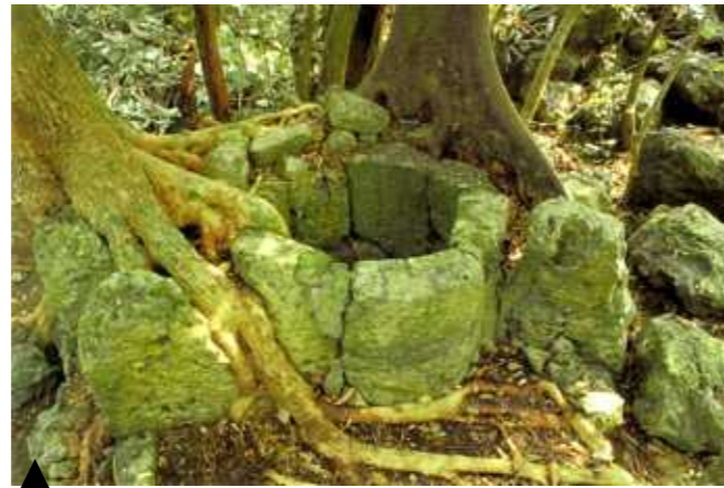
井戸：石積に食い込んだ樹木の根が、歳月を感じさせます。井戸は現在も澄んだ水をたたえ、深さは10数mあります。
