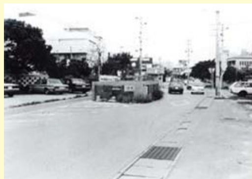
↑バルブボックス（大山）1990（平成2）年鉄筋コンクリート製で、幅2.3m、高さ1.2mほどで、車両は交互に通っていました。
