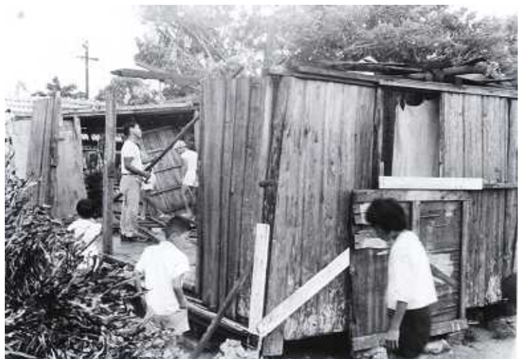
↓ 台風被害 1961(昭和36)年
