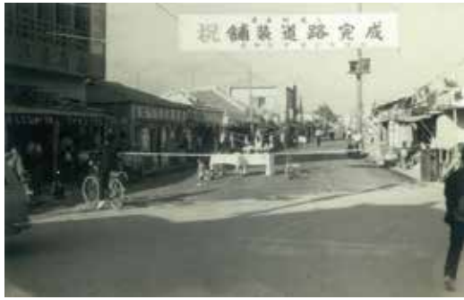
▲ 東本町通り 1965(昭和40)年 宜野湾市商工会議所が送った舗装道路完成の横断幕に目を引きます。
