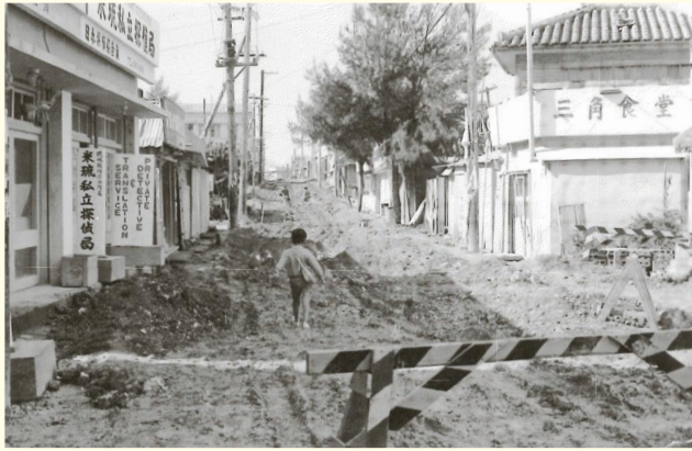
▲新開通り 1966(昭和41)年 舗装、側溝工事の様子で、通り左側に探偵局がありました。右側の食堂は今も営業している老舗の食堂です。
