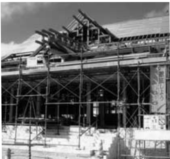
造営工事中の普天満宮
