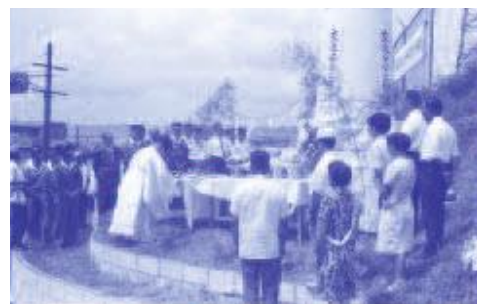
交通安全の祈願祭(1966年)
